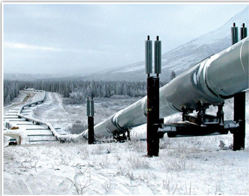
图8 穿越活动断层的输油管线
