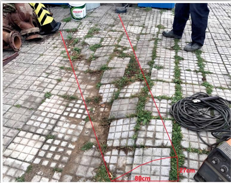
图5 地裂导致路面变形
